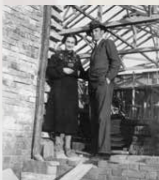
A mozi építése
