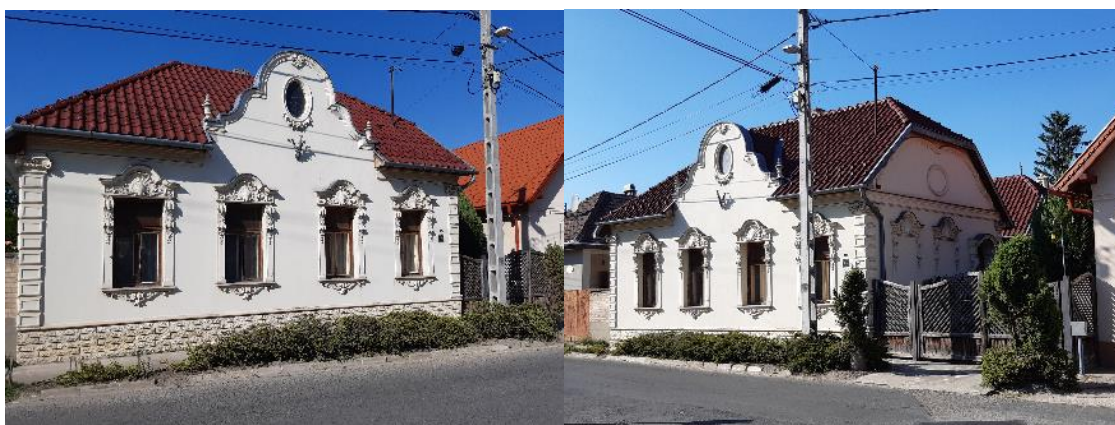
1. kép: Neobarokk lakóház, egykori református parókia – Rákóczi út 55. (foto: MUTK, Kósa Emő)
