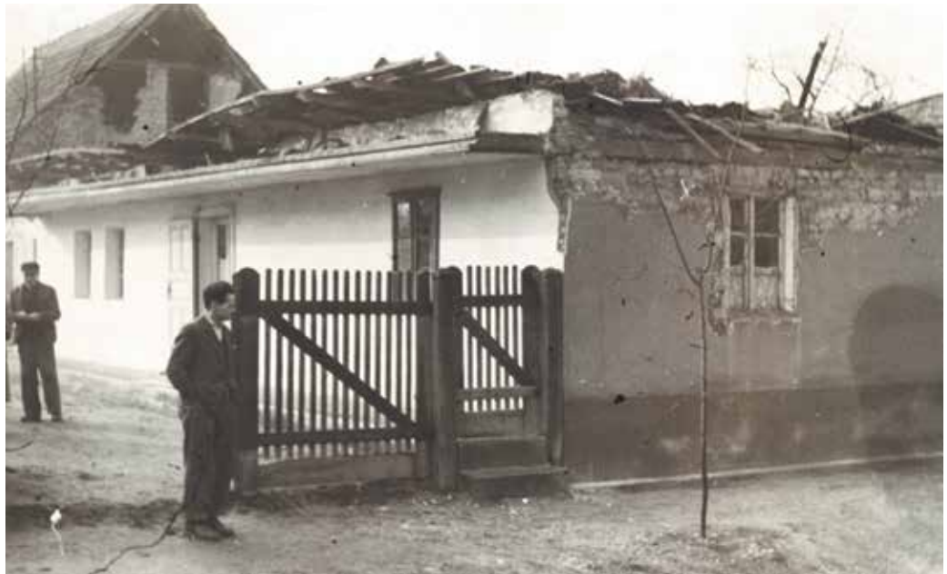
Lakhatatlanná vált ház
