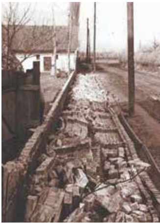
A rengés által kidöntött téglakerítés Szigetszentmiklóson
