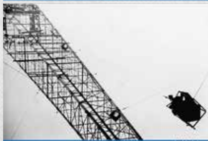
1946: A lakihegyi antennatorony újjáépítése. Szerelőkosárral utaznak 200 m magasra az antennatorony építől.
