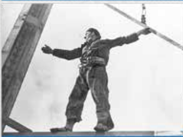
1946: A lakihegyi 314 méter magas antennatorony újjáépítése, szerelő 90 méter magasan.
