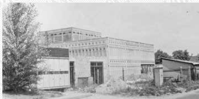
Épül a Márka Skála Áruház Szigetszentmiklóson, 1984–85
